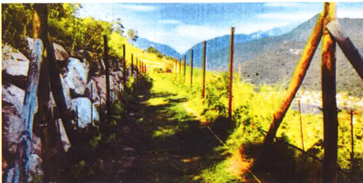
Fotografia n. 3: vista dei particolari realizzativi dell'opera
